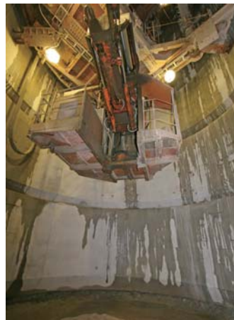
【主立坑の坑底（深度459.6m）】
